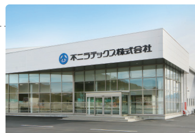
不二ラテックス 栃木千塚工場
